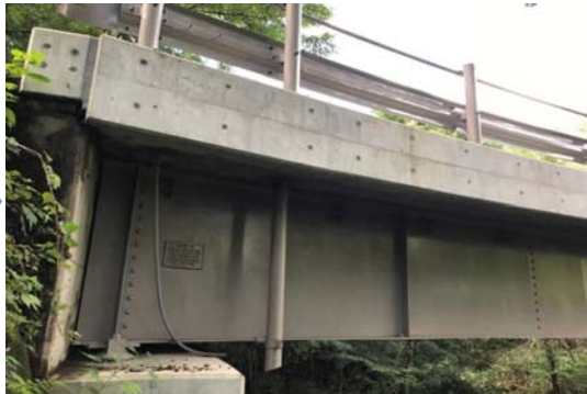
写真4-15 【対策】断面修復
