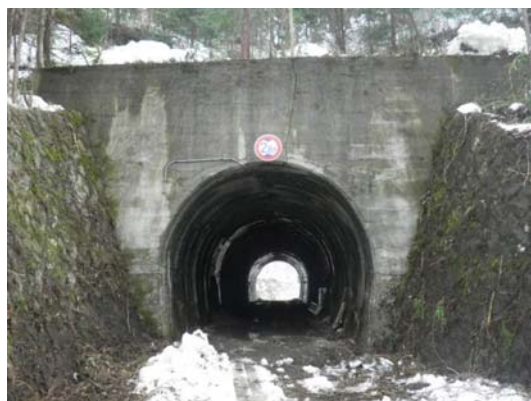
写真4-19 【全景写真】増沢トンネル
