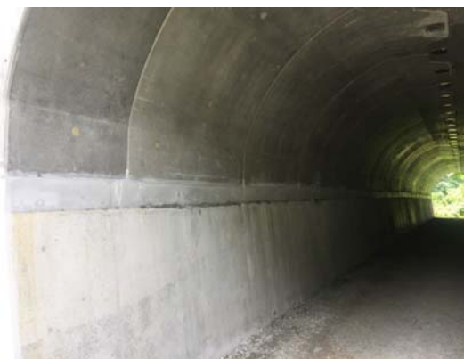
写真4-21 【対策】断面補修工
