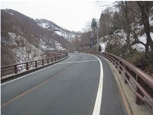
写真4-1 【全景写真】竜川第2陸橋
