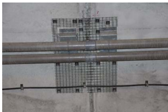
写真4-18 【対策】剥落防止シートの設置
