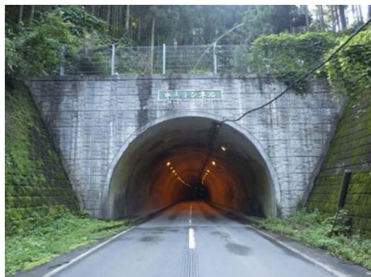
写真4-16 【全景写真】中山トンネル
