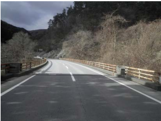
写真4-7 【全景写真】一番沢橋
