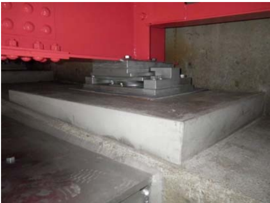
写真4-9 【対策】再塗装、金属溶射
