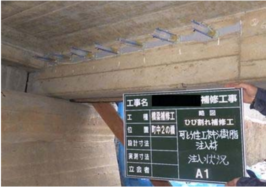
写真4-6 【対策】ひびわれ注入
