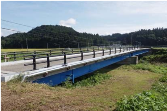
写真4-10 【全景写真】館山橋
