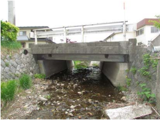
写真4-4 【全景写真】町中2の橋
