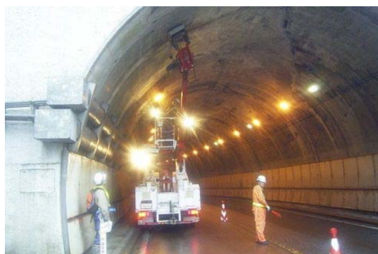
写真3-2 トンネル点検状況
