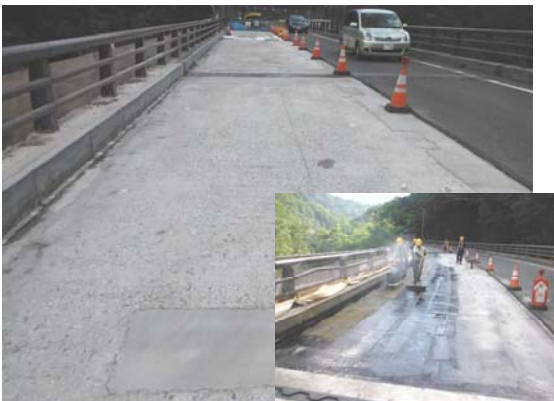
写真4-3 【対策】床版部分打替・防水工
